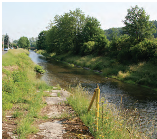
Koryto ciekę po likwidacji rdestowca w dorzeczu Morawki
